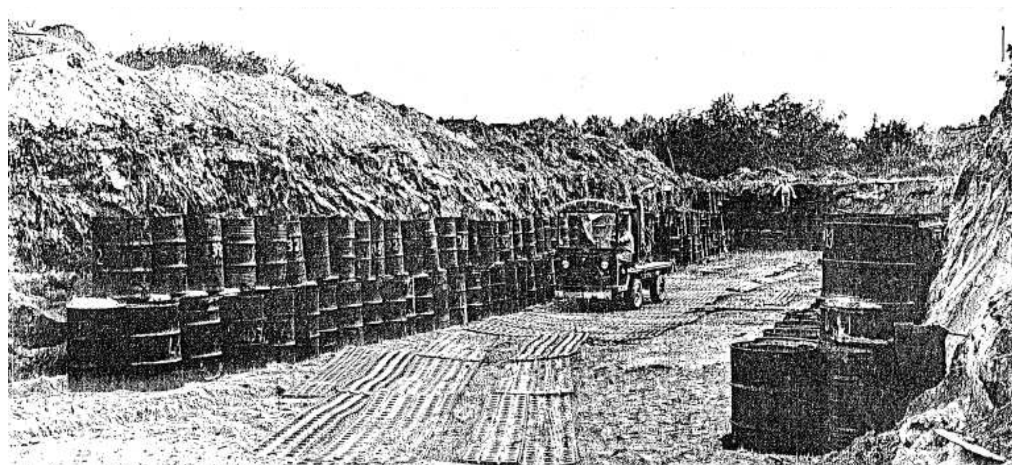
Trincea in fase di riempimento nel 1970
